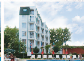
Holiday Apartments & Studios "Lilia" - Солнечный Берег Начало строительства: 26.09.2007 Сдан: 30.04.2008
