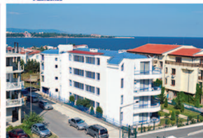
Holiday Apartments & Studios "Blue Marine Residence" - Рава Начало строительства: 17.01.2007 Сдан: 30.05.2008
