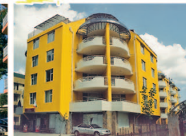
Holiday Apartments "Barco del Sol" - Солнечный берег Начало строительства: 01.05.2004 Сдан: 30.05.2005
