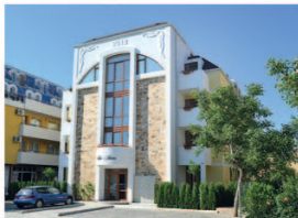
"VILLA FLORA" - Рава Exclusive Holiday Apartments Начало строительства: 16.11.2011 Сдан: 30.07.2012
