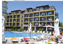
Hotel Studio Apartments "Jasmine Club" - Солнечниот брег Начало строителства: 15.10.2010 Сдан: 30.05.2011
