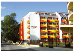
Holiday Apartments & Studios "Orange Residence" - Солнечниот брег Начало строителства: 17.10.2007 Сдан: 30.05.2008
